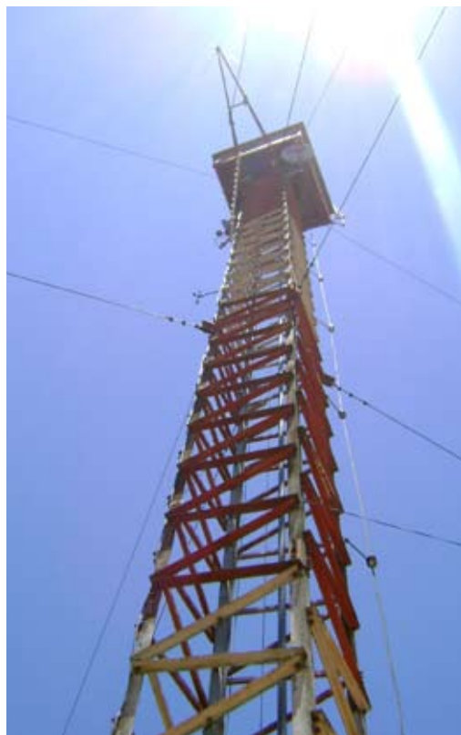
A TORRE DE MONITORAMENTO FUNCIONA COMO UM AMPLIFICADOR DA VISÃO SOBRE A FLONA
