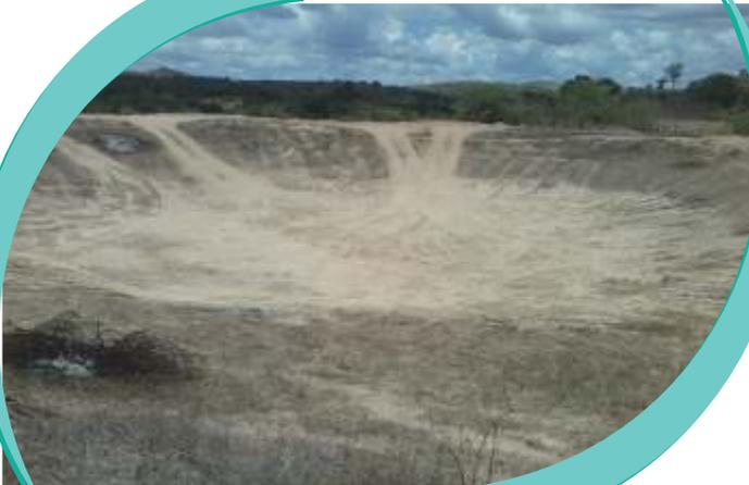
A principal utilidade da Barraginha é segurar a água das enxurradas e garantir sua infiltração no solo, num rápido espaço de tempo, entre uma chuva e outra, aumentando o nível de água nos poços e a umidade nos baixios, permitindo que se faça uma agricultura mais segura. Dessa forma, o sistema de Barraginha possibilita o bom aproveitamento das águas das chuvas, reduzindo sua perda e os danos causados pelas enxurradas.
