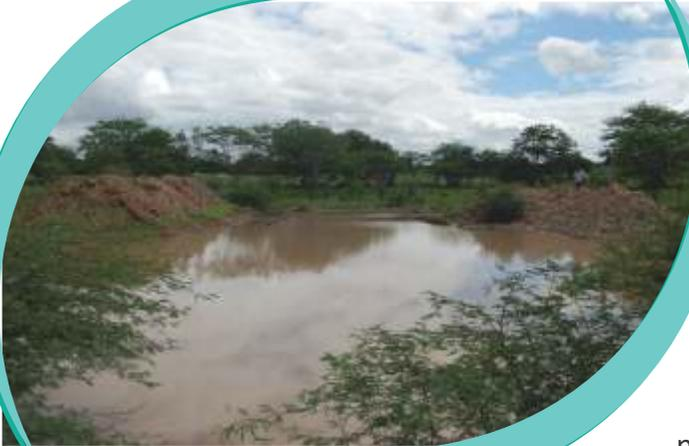
Conhecida também como Barreiro, a Barraginha é um açude pequeno construído em terrenos desgastados pela erosão provocada pela água. A Barraginha é feita em forma de semicírculo ou concha, com aproximadamente 16m (dezesseis metros) de diâmetro.
